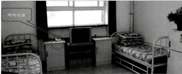
图2 养老院呼叫设施
