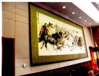
① 国务院会议室软包装饰墙面
