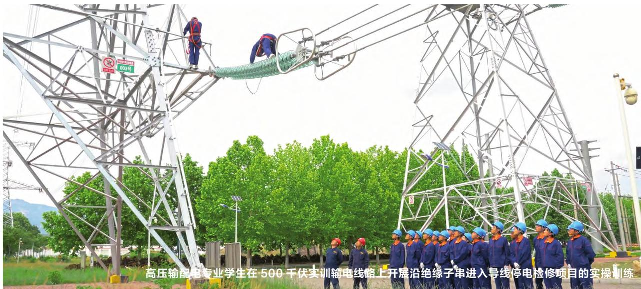
高压输配电专业学生在 500 千伏实训输电线路上开展沿绝缘子串进入导线停电检修项目的实操训练
