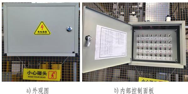
图3 教学用电梯电气故障箱实物
